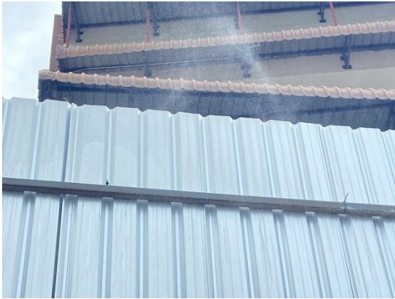
รูปที่ 13 การติดตั้งสเปรย์น้ำ
